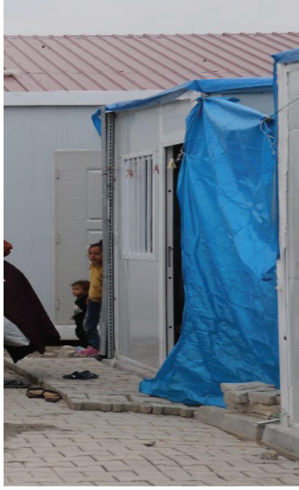
Şekil 8 Hatay’da iki konteyner arasında branda gerilerek oluşturulan depolama alanı.
